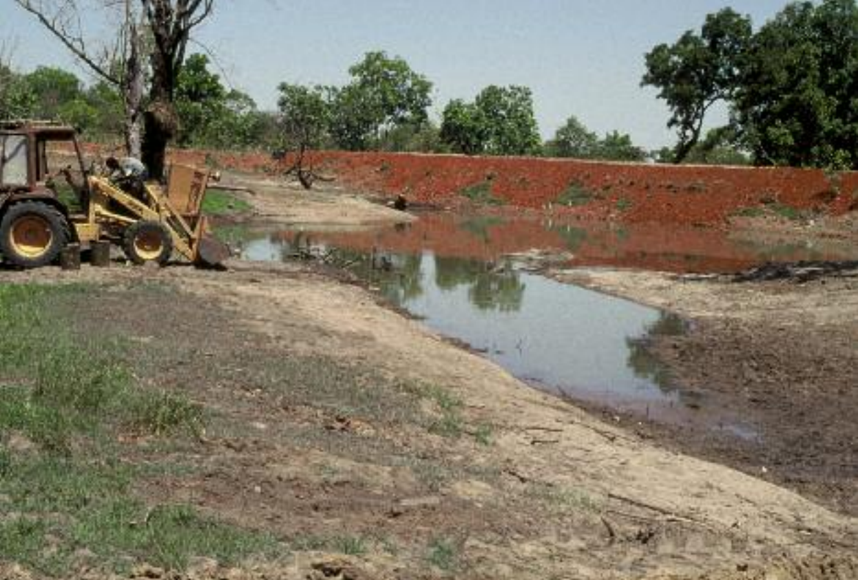
Un petit barrage en cours de construction
